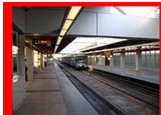
A 2-es metró Pillangó utcai állomása a felújítás után
